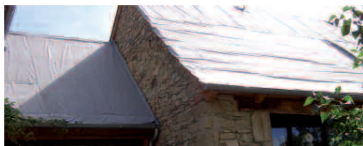
Restauration et agrandissement avec toiture en attente de lauze.
