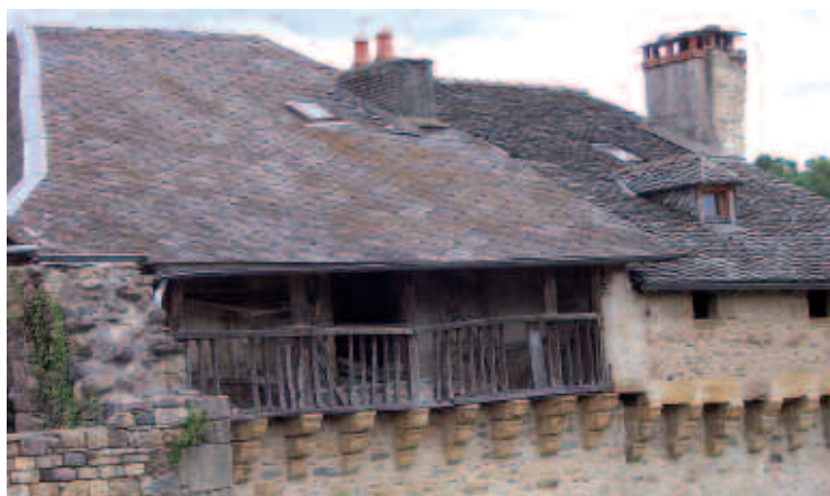
Ardoise amiante-ciment (à gauche) et lauze (à droite) sur monument classé (Aveyron).
