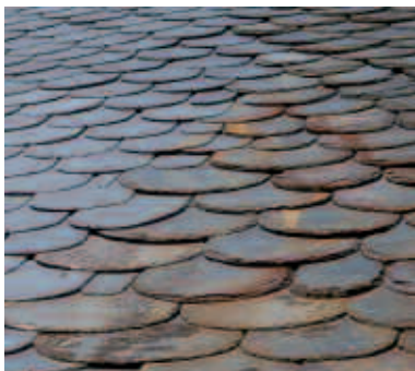
En haut : toiture en Lauze du Cayrol avec faitage en peigne.
