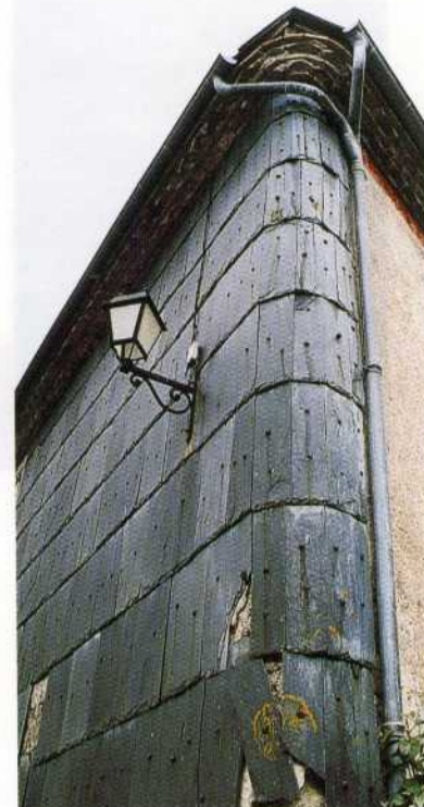
Façade d'une maison de village protégée par un bardage en schiste. En face, la mairie d'Arfons.
