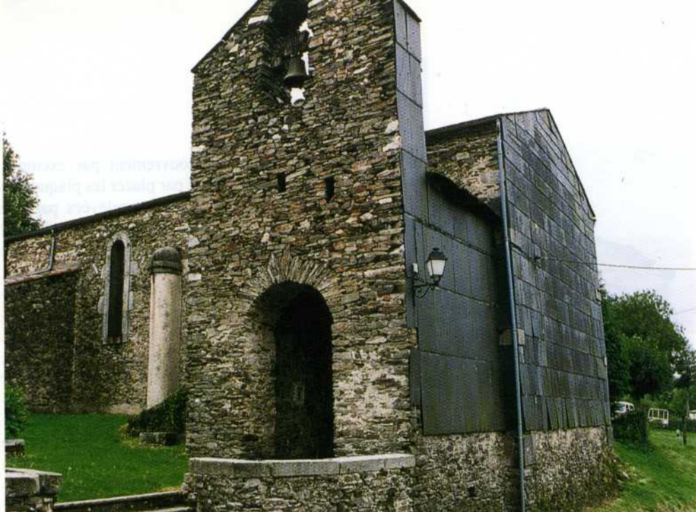
Recouvrement mural en plaques de schiste. Les Escudiés à Arfons (Tarn).
