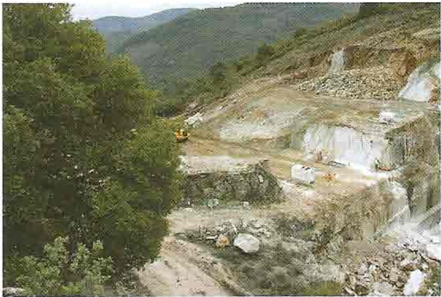
La masse se trouve sous environ 1 m de découverte. Le premier banc, de 2 m de haut, particulièrement fissuré est dédié au concassage.
